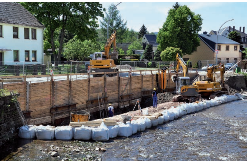
Rechts: Die Hochwasserschutzanlage an der Kaditzer Flutrinne ist fertig
