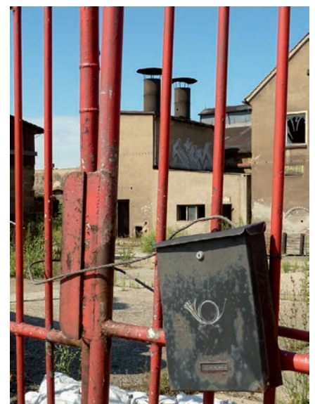
Die Brache der ehemaligen Gießerei in Bautzen-Süd wird derzeit abgerissen
