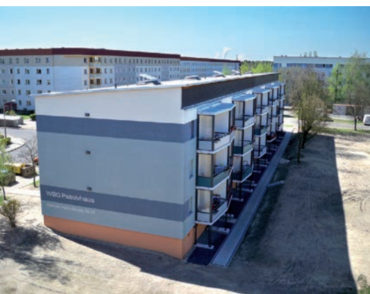
Der EFRE fördert umweltfreundliche Verkehrsträger (oben) und weitere Maßnahmen zur Verringerung der CO 2 -Emissionen, wie hier die Errichtung eines Passivhauses
