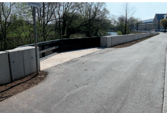
Flöha ist nun vor einem 100-jährlichen Hochwasser geschützt
