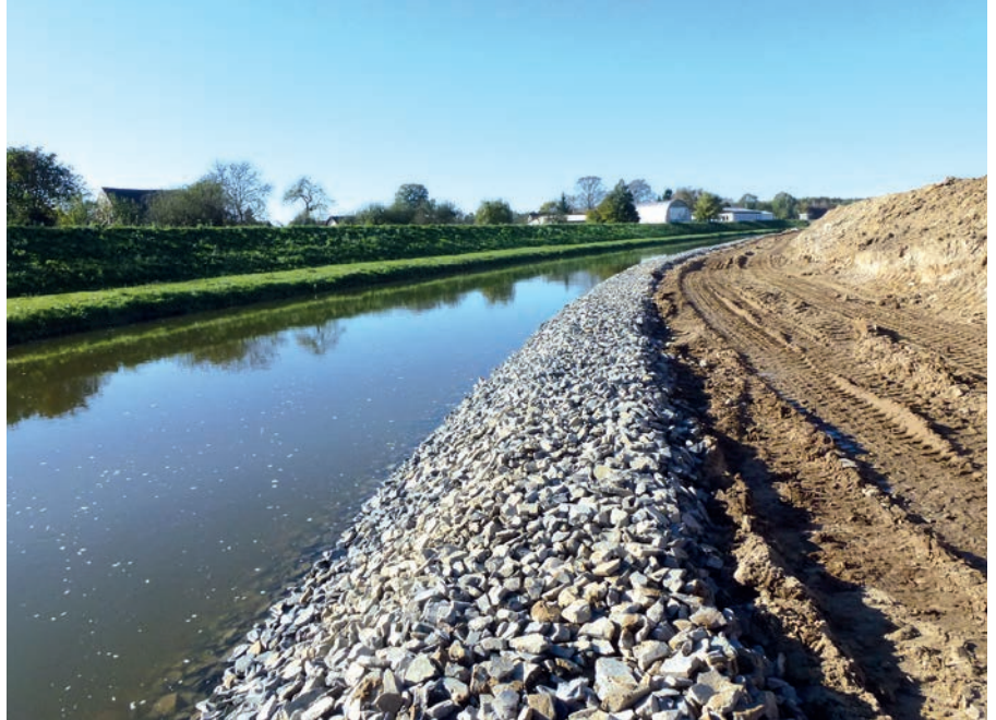
In Neuwiese wurde der Deich auf 700 Metern Länge erneuert
