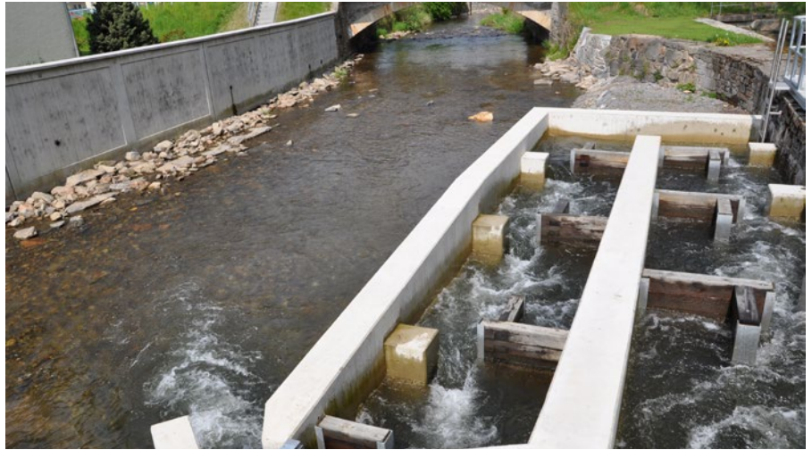
Neue Hochwasserschutzmauer und umgebaute Wehranlage mit Fischaufstieg in Mulda
