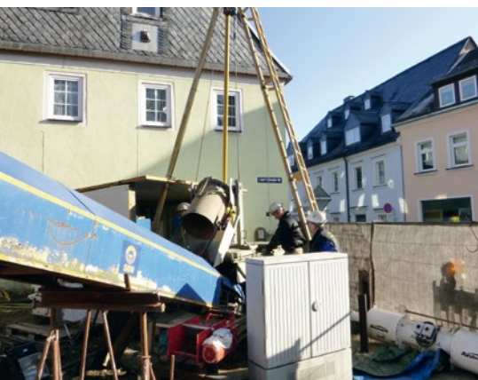
Schachtanlage (Zugang zum Stolln)
