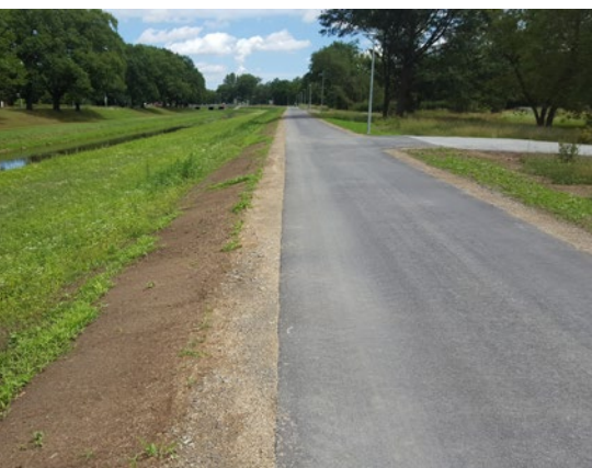
Fertiggestellter Deichabschnitt in Hoyerswerda
