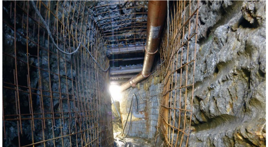
Sanierungsarbeiten im Stolln
