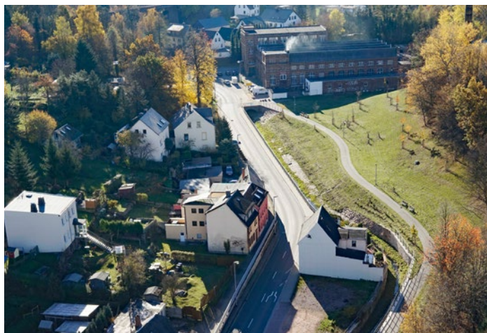
Links: Grünraumgestaltung entlang des Altmittweidaer Baches
