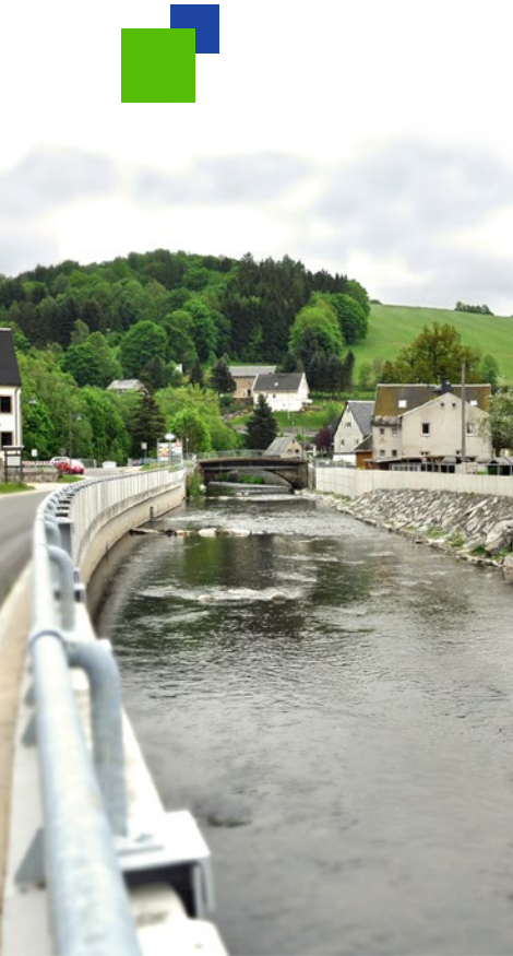
Wiesa ist jetzt vor Hochwasser geschützt
