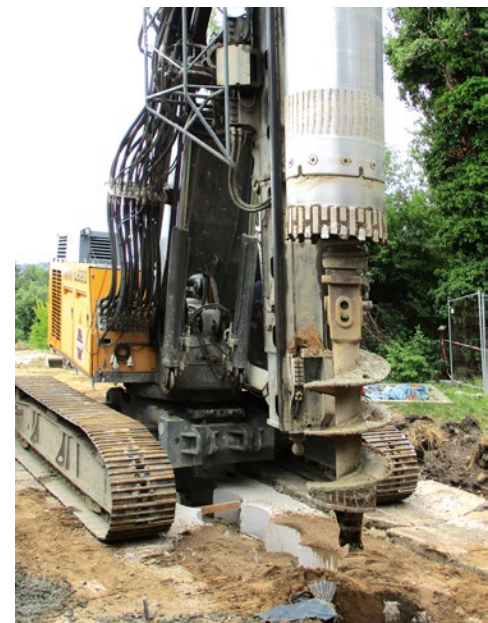
In Radebeul-Fürstenhain wird am neuen Deich gearbeitet
