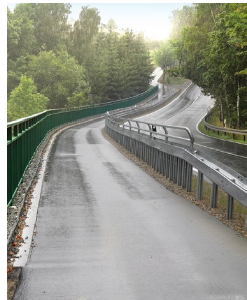
EU-Förderung für Bau des straßenbegleitenden Geh- und Radwegs von Möschwitz bis zur Talsperre Pöhl
