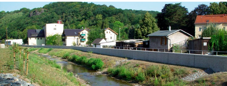
Die neue Hochwasserschutzanlage in Meißen-Buschbad wurde vom Europäischen Fonds für regionale Entwicklung mitfinanziert
