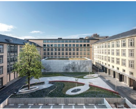
Der sanierte Barkhausenbau der TU Dresden ist das Domizil des cfaed
