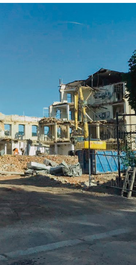
oben: Historische Aufnahme der Strumpffabrik unten: Beim Abriss
