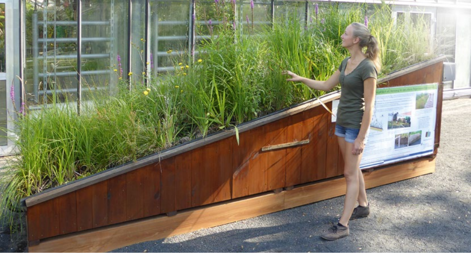
Beispiel für ein Sumpfpflanzendach, das auf einer der vier Versuchsflächen entstehen soll
