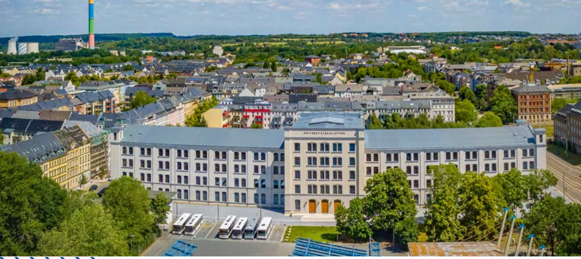
Blick von oben auf die Alte Aktienspinnerei, jetzt Unibibliothek der TU Chemnitz
