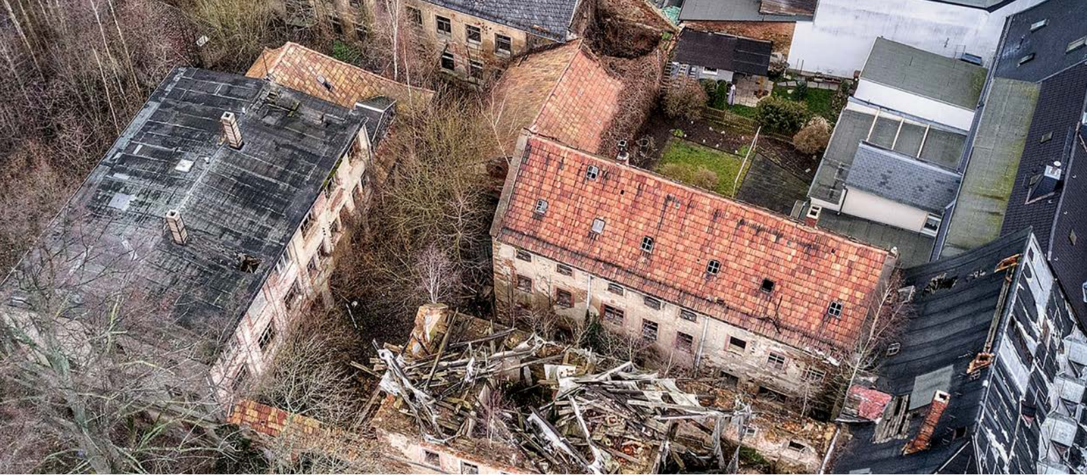
Das ehemalige Welkersche Gut wird saniert
