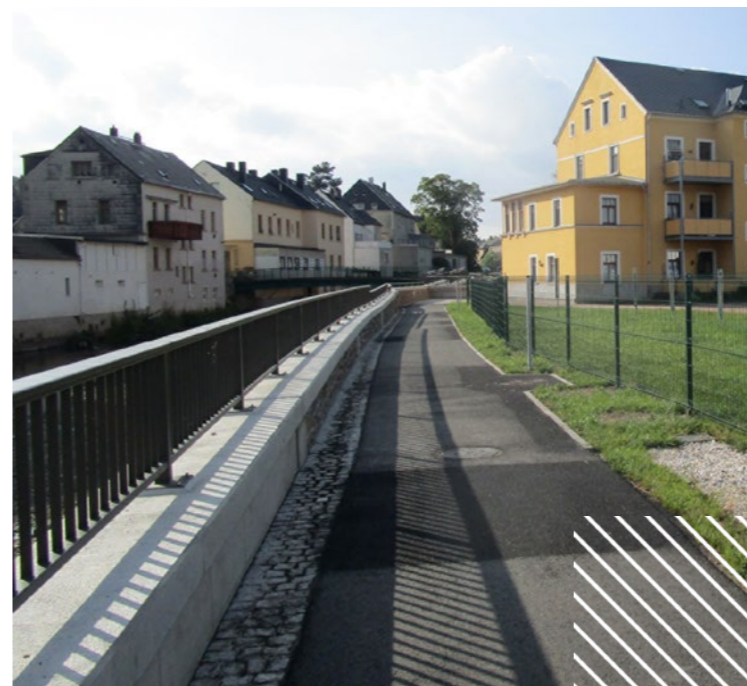
Olbernhau ist jetzt vor Hochwasser geschützt
