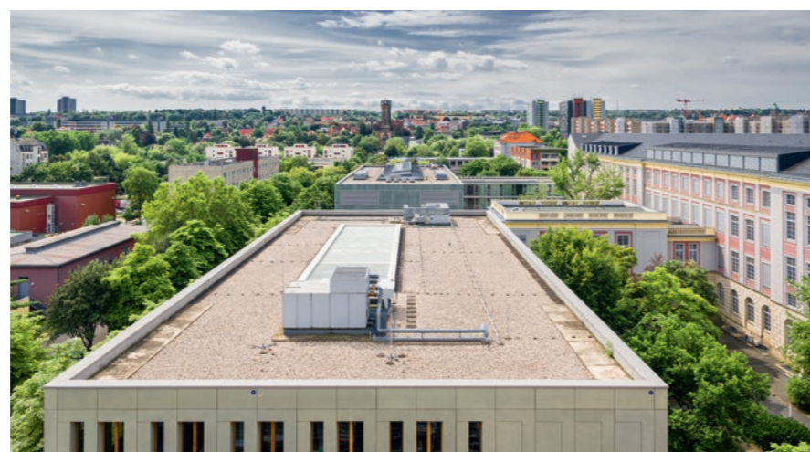
Blick über den Neubau
